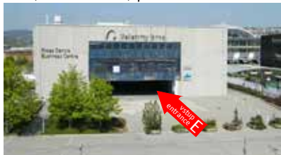
Brno, Křížkovského, pavilon E
