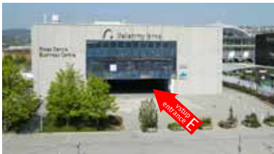
Brno, Krížkovského street, hall E
